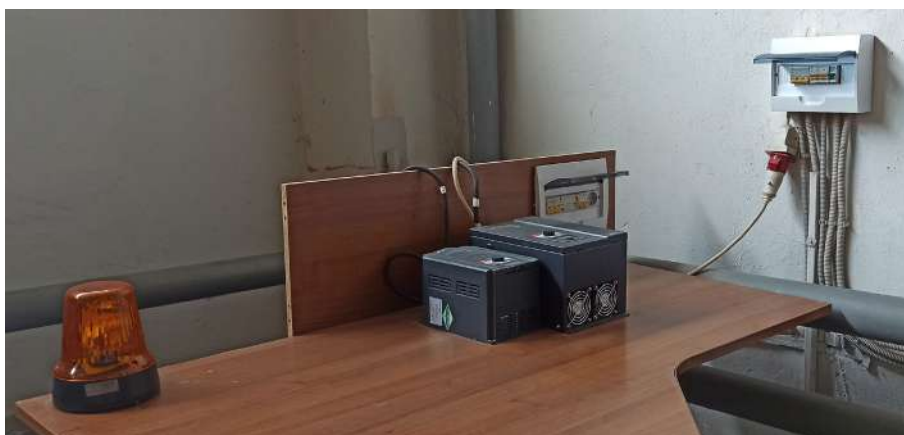
Р и с. 9. Общий вид пульта управления электрическими двигателями приводов перемещения подвижного модуля и вращения испытываемых ведущих колес
